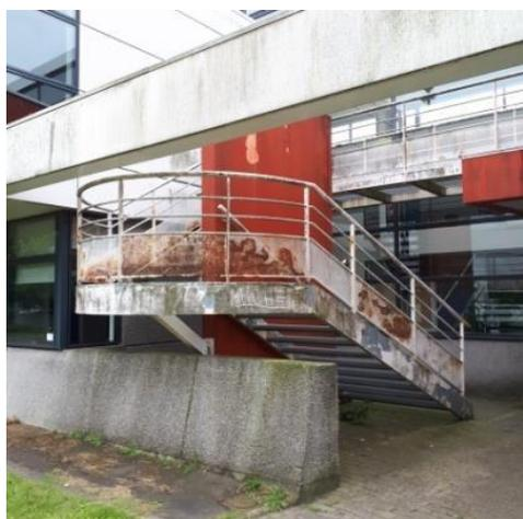
**L'escalier de secours** situé en façade Nord et desservant le R+1 souffrent de désordre liés à la **carbonatation des bétons et la corrosion des aciers**. Les ouvrages seront à réparer et à renforcer dans le cadre des travaux.
