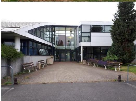
**Le remplacement des menuiseries extérieures et des complexes d'isolation des façades permettront d'améliorer significativement la performance thermique de l'enveloppe.**
